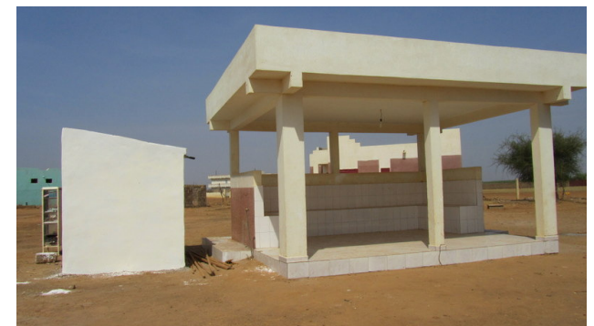
Distributeur de tickets et salle d'attente
