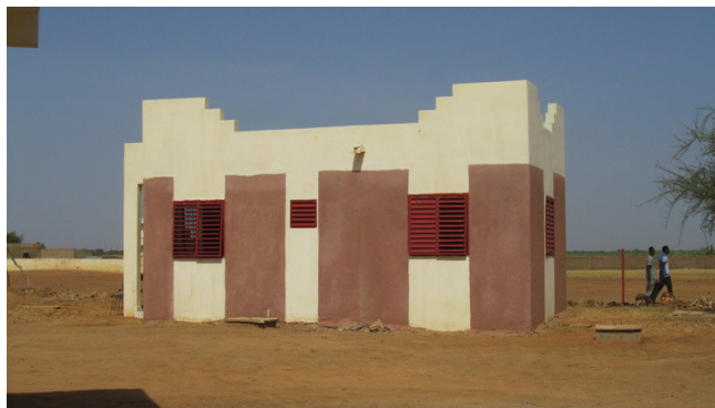
Logement de fonction
